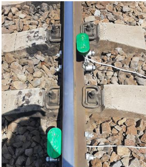
Рис. 4. Установка датчиков для объемной диагностики колес проходящего поезда и счета осей
