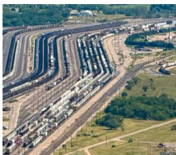
Рис. 1. Фрагмент железнодорожной станции Бейли-Ярд [10]
