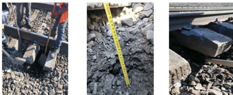
Рис. 1. Определение толщины и загрязненности балластного слоя
